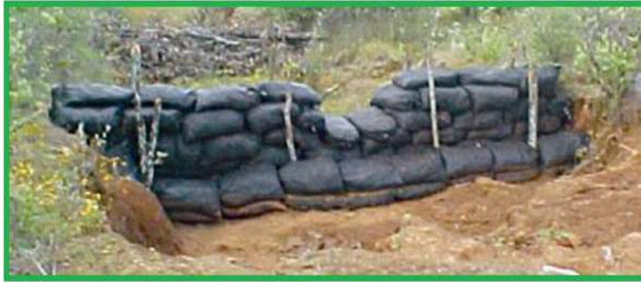
Fig. 27. Imagen de una presa de geocostal.
