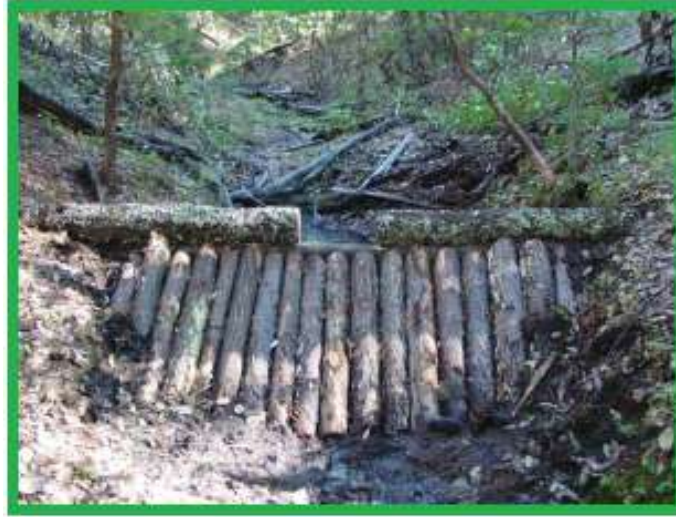
Fig. 30. Imagen de una presa de morillos.
